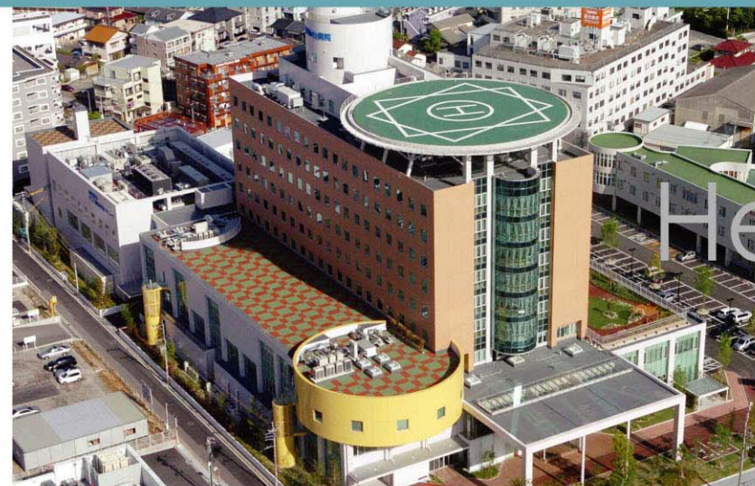
和白病院屋上ヘリポート
